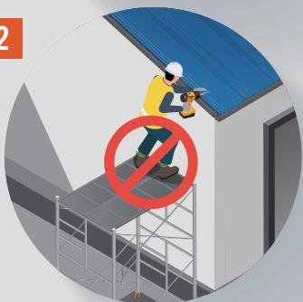
무엇이 위험한가요? 안전난간 설치상태 불량 또는 미설치
